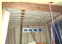
外壁断熱工事の例
