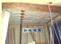
外壁断熱工事の例
