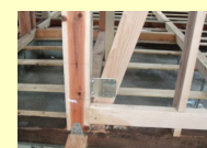
耐震補強工事の例
